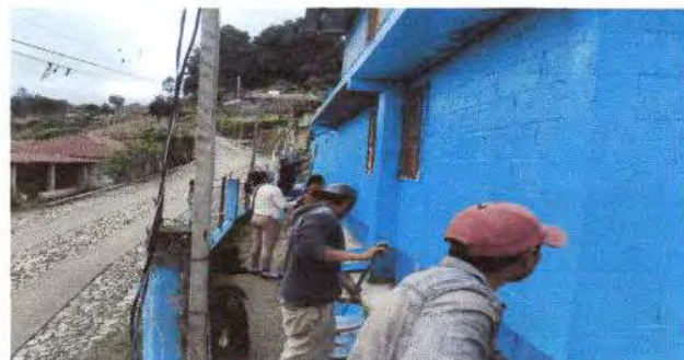
Foto 10: Pintura en muros exteriores e interiores
