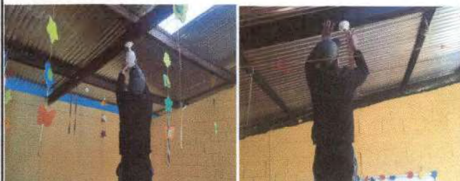
Foto13: Sustitución de focos ahorradores, plafoneras, interruptores simples, tomacorrientes dobles, ducto electrico mas accesorios
