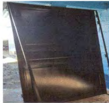
Foto 4: Sustrucción de puerta
