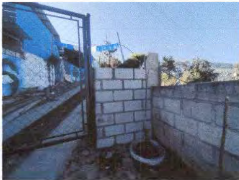
Foto15: Reparación de muro perimetral de block, entrada principal
