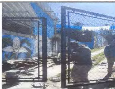
Foto 11: Mantenimiento a portones de metal
