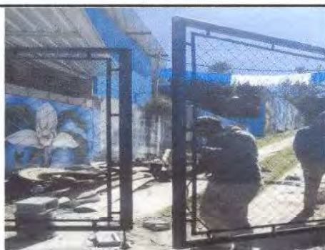
Foto 11: Mantenimiento a portones de metal
