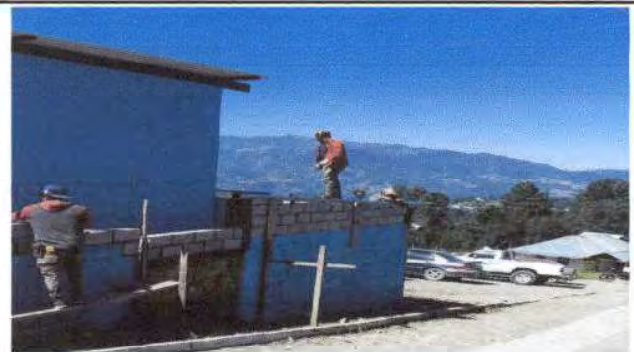
Foto 16: Reparación de muro perimetral de block.
