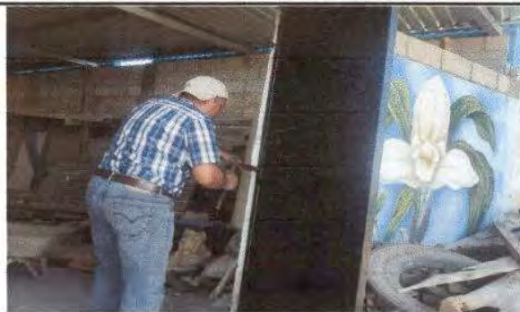
Foto 6: Sustitución de portón de metal
