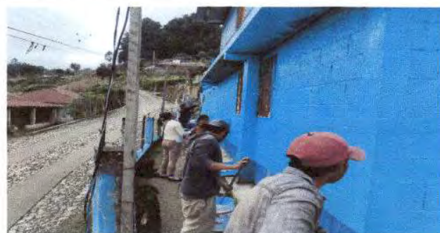
Foto 10: Pintura en muros exteriores e interiores
