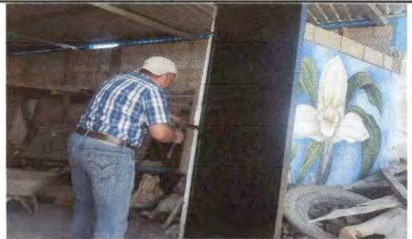
Foto 6: Sustrucción de portón de metal
