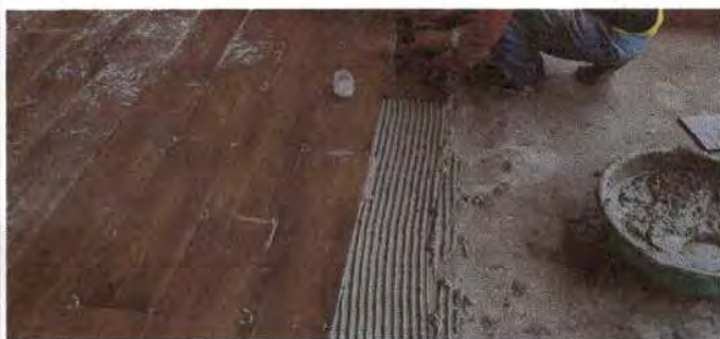
Foto 9: Sustitución de piso cerámico
