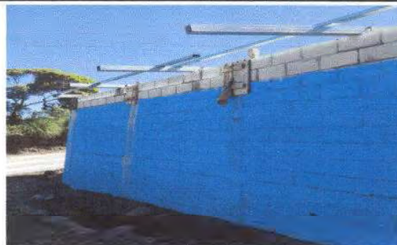
Foto 14: Reparación de muro perimetral para cubierta de lamina en bodega
