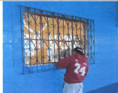
Foto 8: Mantenimiento a balcones de metal
