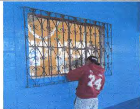
Foto 8: Mantenimiento a balcones de metal
