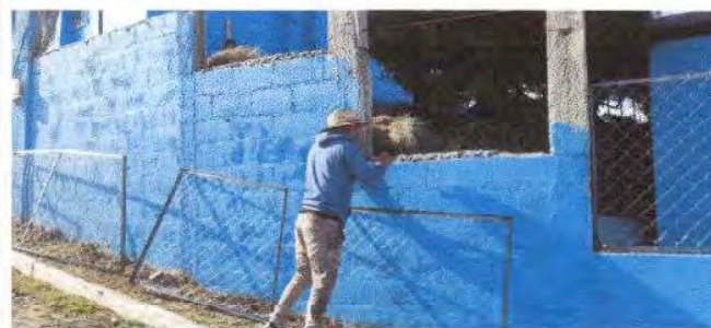
Foto 12: Reparación de muro perimetral de block con tubo hg y malla galvanizada, soleras intermedias y columnas
