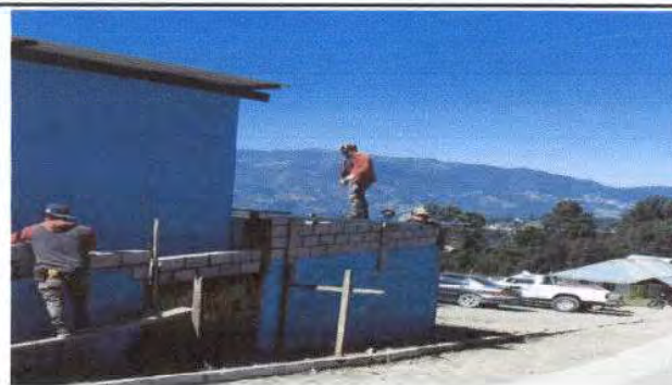
Foto 16: Reparación de muro perimetral de block.
