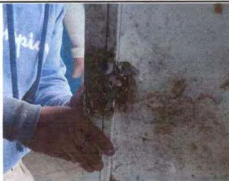
Foto 3: Sustitución de chapa
