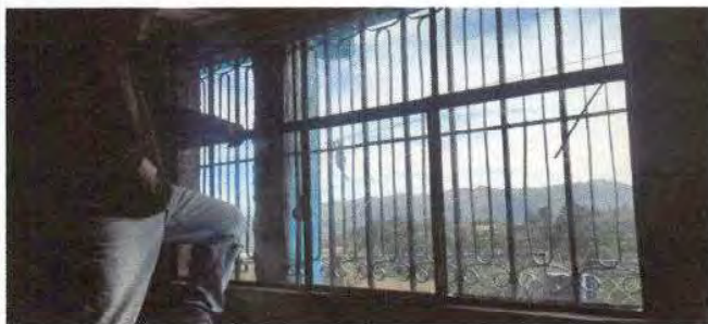
Foto7: Sustitución de vidrios
